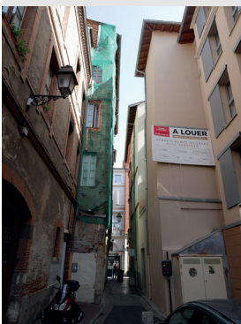
Vue depuis la très étroite rue Malcousinat Photo : SARL MIK MAK
