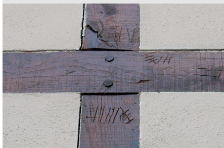
Marquages d'assemblage du colombage Photo : Envirobot Occitanie
