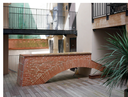
Arche visible depuis la cour intérieure Photo : Envirobot Occitanie
